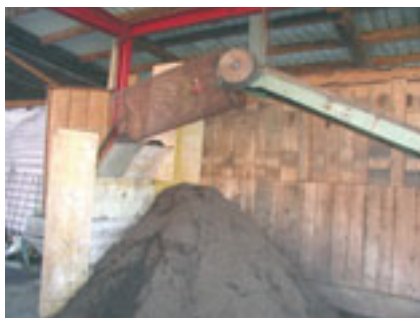
Fraction solide du digestat après séchage, Reidermoos (LU)
