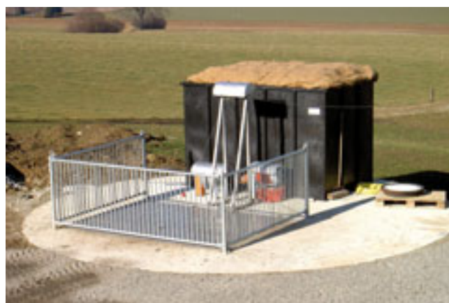
Biofiltre surmontant la préfosse
