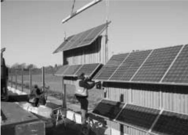
Montage sur l'autoroute: murs antibruit équipés de modules photovoltaïques (photo: Atelier Hottiger)
