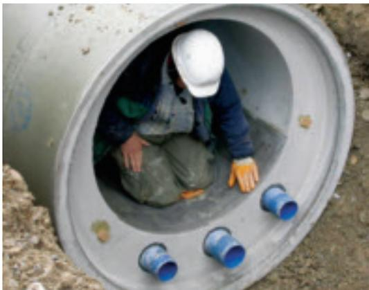
Fig. 2 Echangeur de chaleur intégré dans le collecteur.
