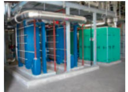
Fig. 4 Echangeur à plaques d'une installation de séchage des boues de STEP.
