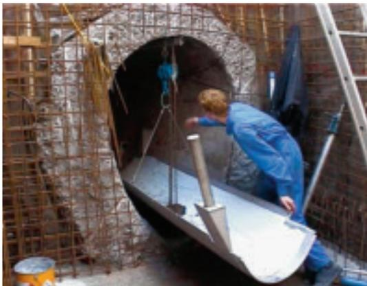
Fig. 3 Installation d'un échangeur dans un collecteur ovoïde.
