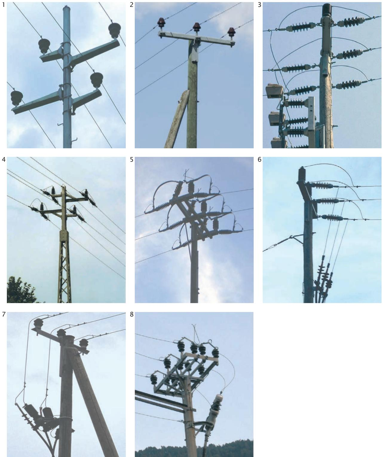
*Fig. 4: La plupart des accidents surviennent sur des mâts avec isolateurs-supports et des conducteurs passant au-dessus des consoles (1-8), sur des interrupteurs dangereux (5, 8) et sur des mâts d'arrêt (avec ou sans interrupteurs 6-8). (Photos: A. Aebischer et CFF)*
