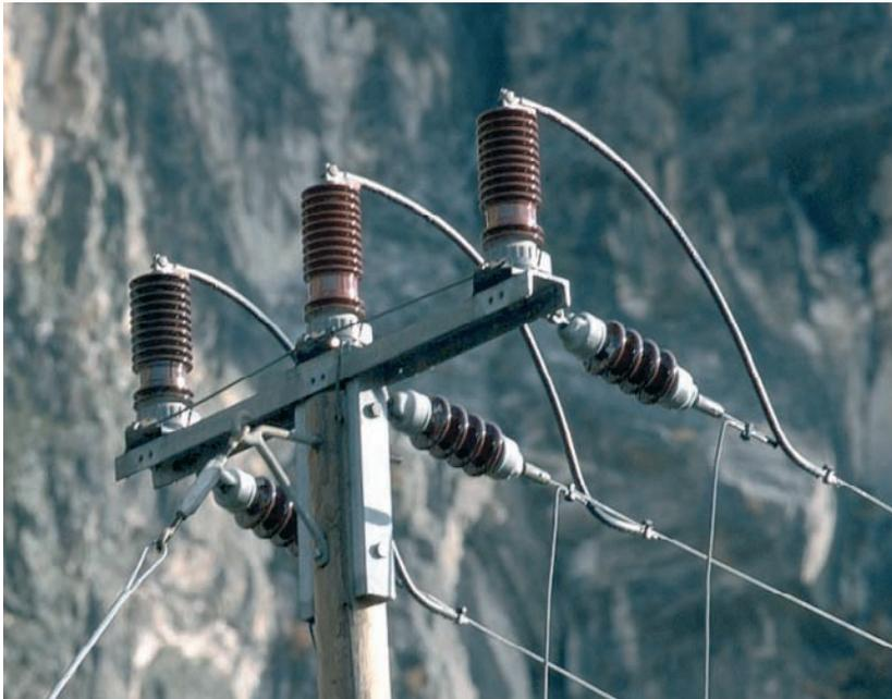
*Fig. 6: Après l'accident survenu à un hibou grand-duc sur ce pylône d'arrêt, les trois parafoudres ont été isolés. (Photo: R. Arlettaz)*
