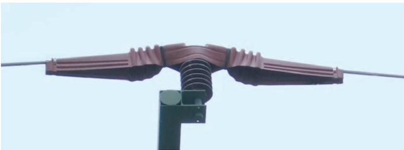
*Fig. 7: Isolateurs dressés avec calottes de recouvrement. Le matériel de couverture isolant doit couvrir les conducteurs des deux côtés des isolateurs sur une longueur d'au moins 60 cm. (Photo: A. Aebischer)*
