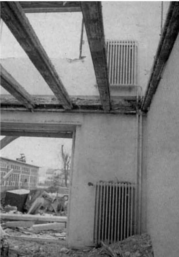
*Illustration 4-3: Démontage jusqu'à la structure porteuse.*
