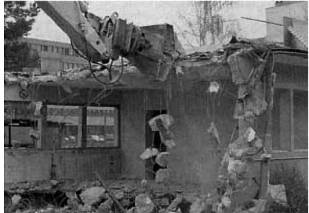
*Illustration 4-4: Mise en œuvre d'outils spéciaux (cisaille à béton).*
