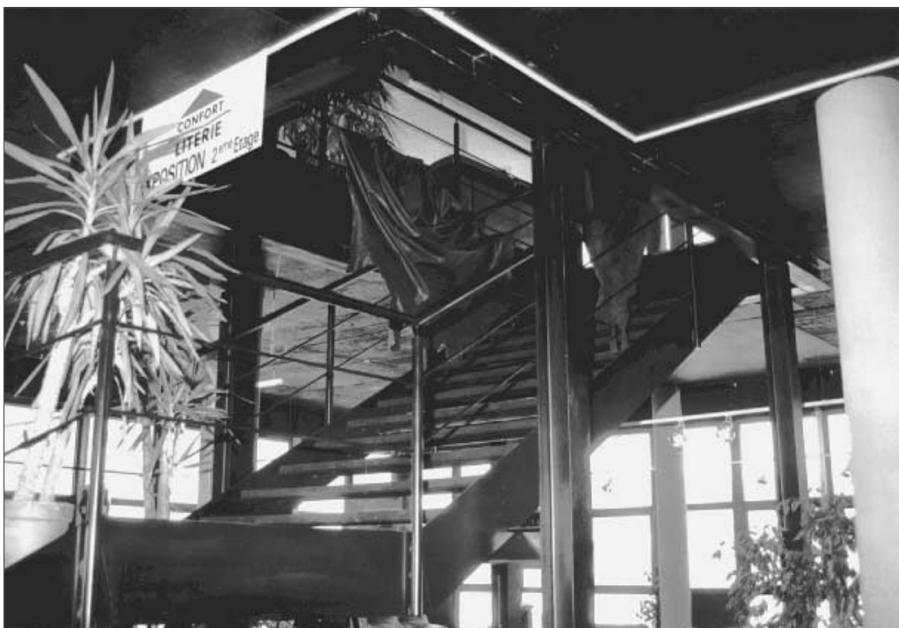
Figure 7.8: Création d'une ouverture dans une dalle; renforcement par des profilés en acier.
