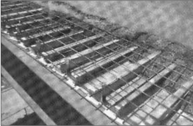
Figure 6.17: Construction mixte (photo: ICOM-EPFL).
