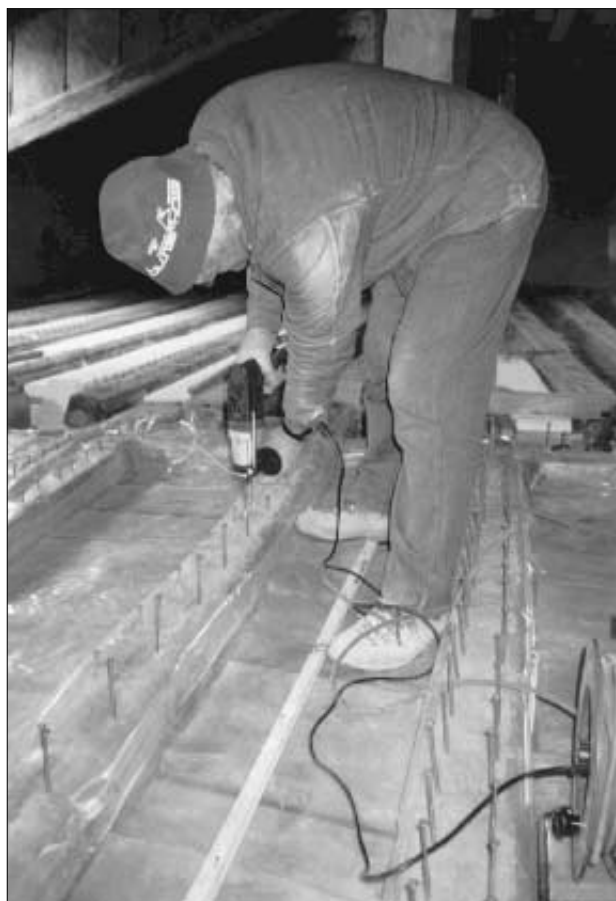
Figure 6.26: Liaison mixte avec des vis à bois (photo: Uldry-Dufour).
