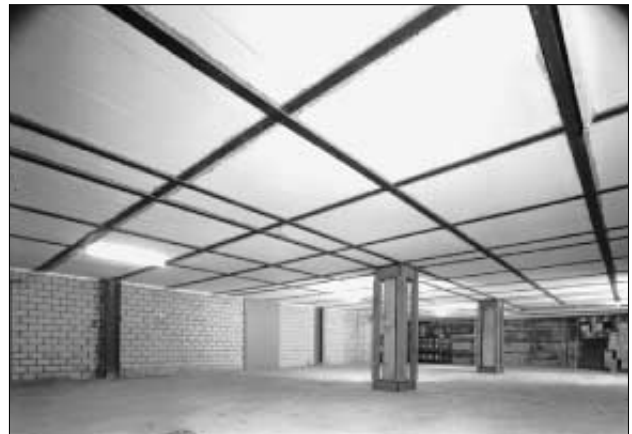
Figure 7.18: Exemples de renforcements au moyen d'armature collée (photos: Stahlton SA, Zurich).
