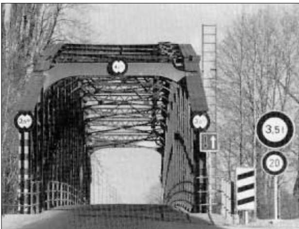
Figure 1.6: Restrictions avant la rénovation (photo: SI+A, cahier N° 41, 10.10.1991/975, la chaussée en acier pour la rénovation du pont, Hans-Gerhard Dauner, Aigle).
