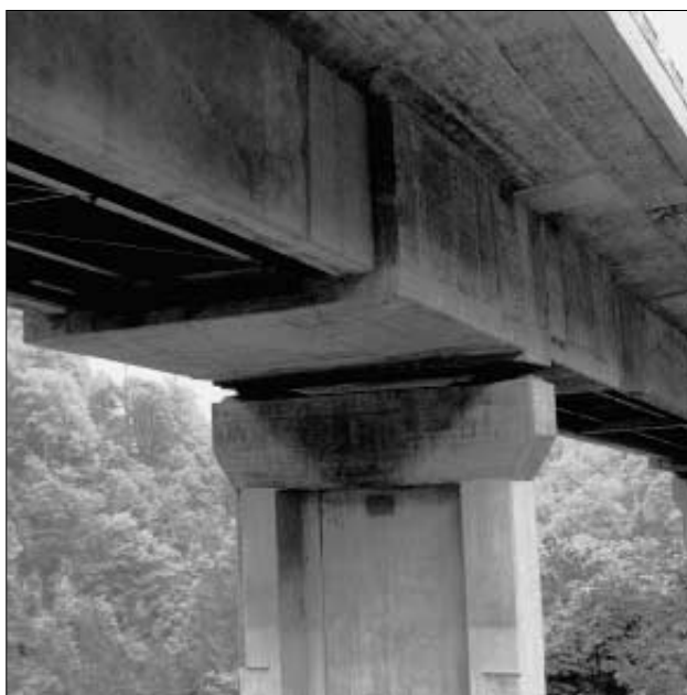
Figure 6.7: Renforcement de l'âme d'une poutre (photo: Service des travaux publics, canton d'Uri).
