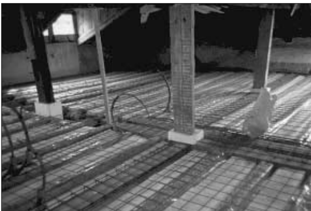
Figure 6.24: Dalle mixte de bâtiment avant le bétonnage (photo: Uldry-Dufour).
