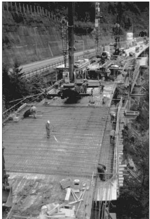
Figure 6.6 : Renforcement d'un tablier (photo : Service des travaux publics, canton d'Uri).
