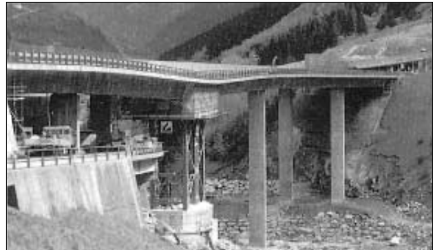
Figure 8.2: Pont sur la Reuss à Wassen. Etat du pont avant le levage et la mise en place de câbles de précontrainte extérieurs (Lüpold, 1988).
