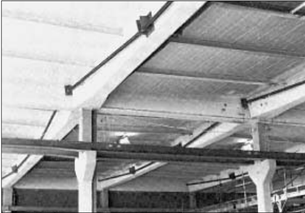
Figure 8.4: Précontrainte de poutres en béton dans un bâtiment industriel, réalisation en 1988/89 (Heer, 1989).
