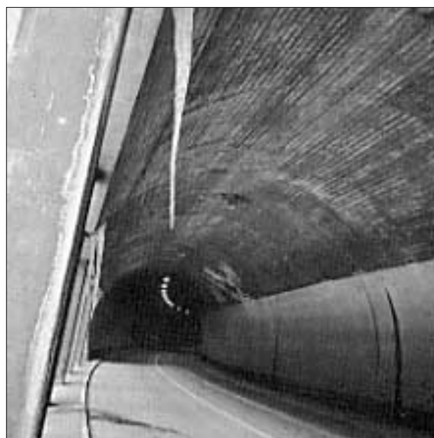
Figure 3.14: Formation de stalactites de glace à la perforation des joints de dilatation par de l'eau
