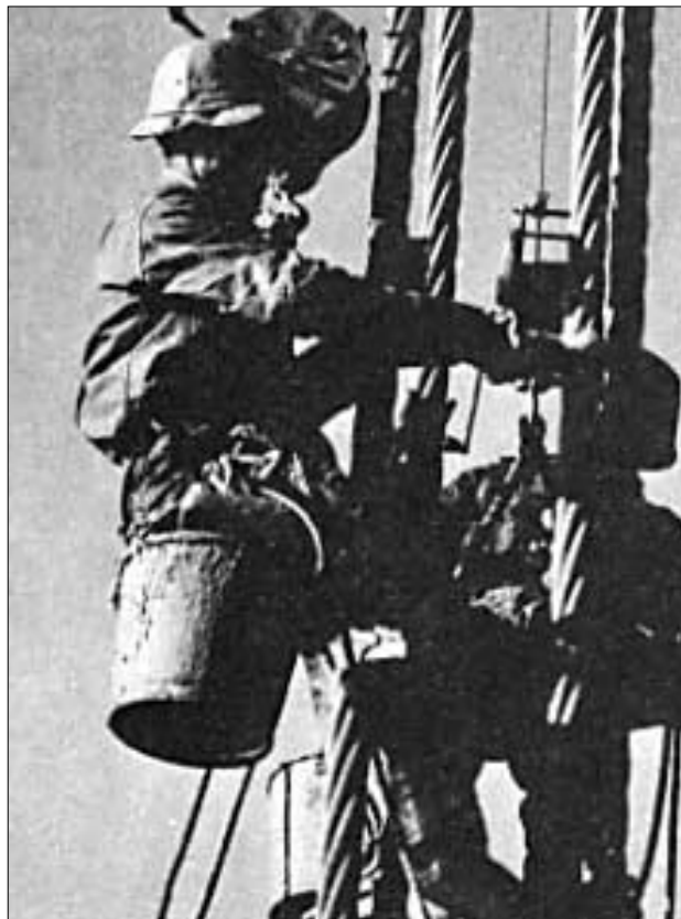
Figure 5.3: Golden Gate Bridge – Dans sa nacelle, un ouvrier travaille au traitement anticorrosion d'un câble de suspension, voir [5.5]
