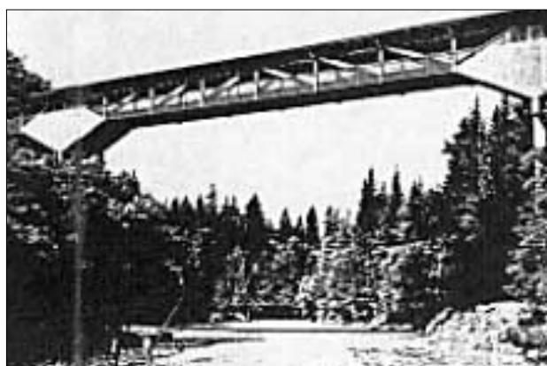
Figure 6.2: Ouvrage de génie civil récent. La protection du bois a été soigneusement pensée. Pont de Wimmis, Berne
