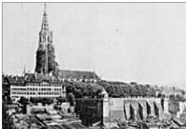
Figure 7.4: Le mur de soutènement de la place du Münster à Berne
