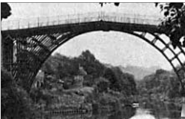
Figure 5.1: Pont arc en fonte sur la Severn près de Coalbrookdale – portée de 30 m, voir [5.1]
