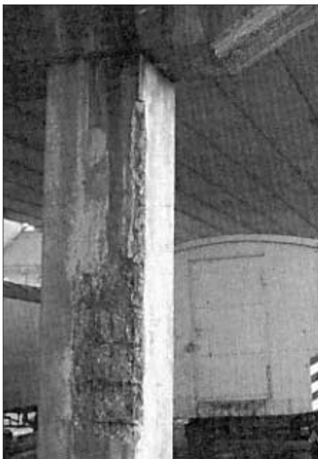
Figure 4.4: Dégradations dues à la corrosion de l'acier d'armature. Documents photographiques tirés de [4.7]
