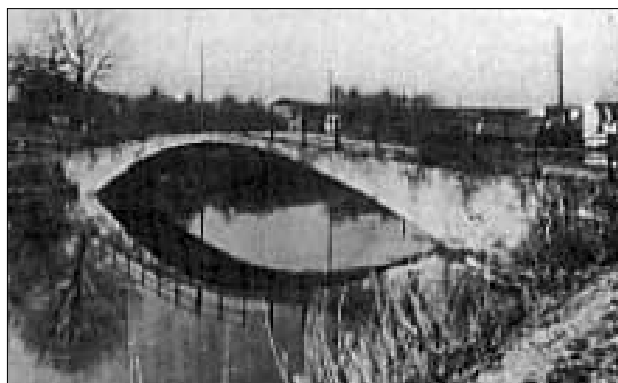
Figure 4.1: Le premier pont en béton armé qui ait été construit en Suisse a été érigé en 1890 au-dessus d'un canal proche de Wildegg (selon [4.1])
