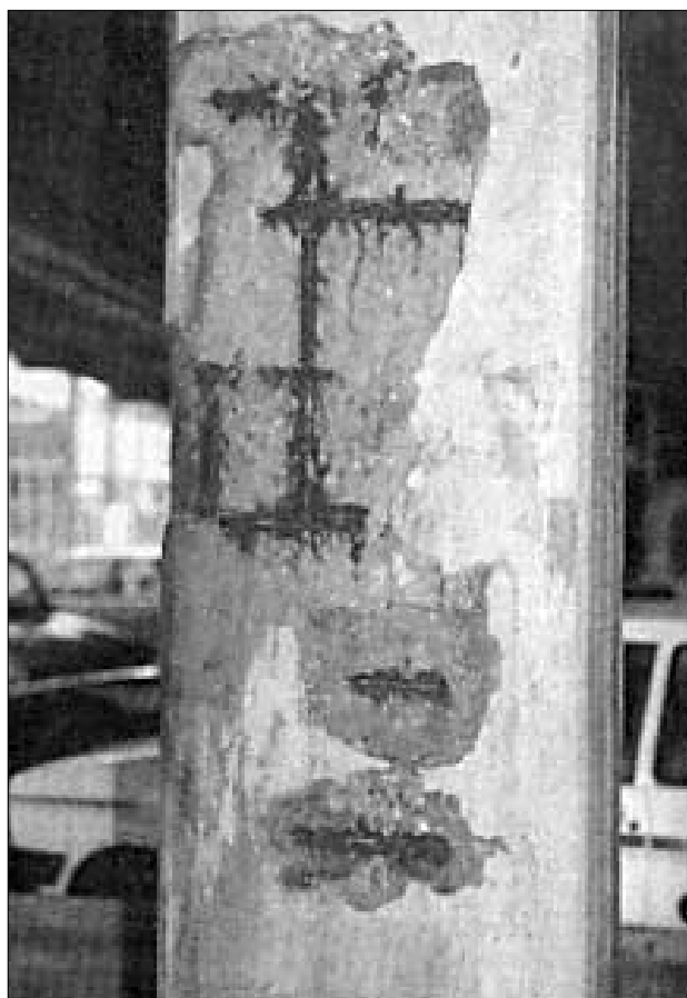
Figure 4.4: Dégradations dues à la corrosion de l'acier d'armature. Documents photographiques tirés de [4.7]
