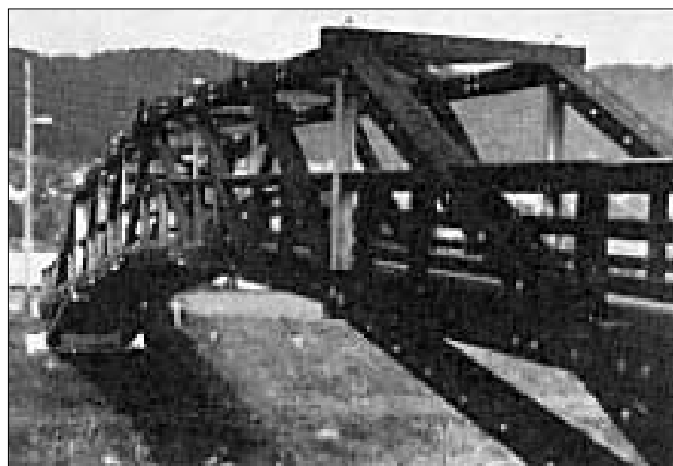
Figure 6.12: La conception globale constitue le premier pas vers une optimisation du concept de protection. Les constructions ouvertes et non couvertes impliquent une foule de détails «déliés» – en particulier les points d'articulation – dont la protection s'avère difficile à assurer
