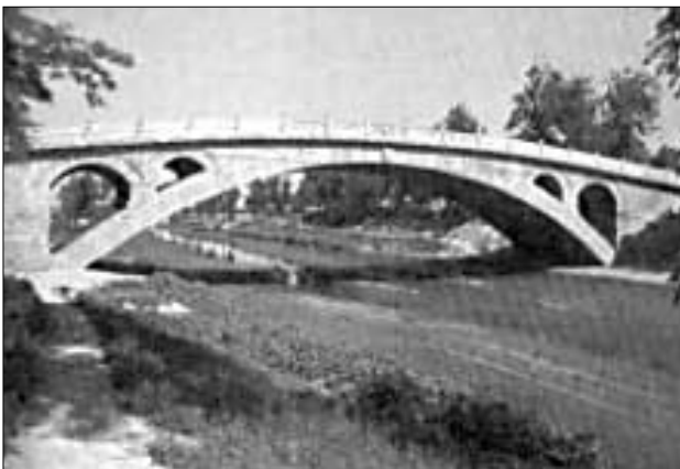
Figure 7.1: Le pont de Zhaozhou près de Zhaoxian dans la province de Hebei, Chine. Portée: 37,02 m. [7.1]
