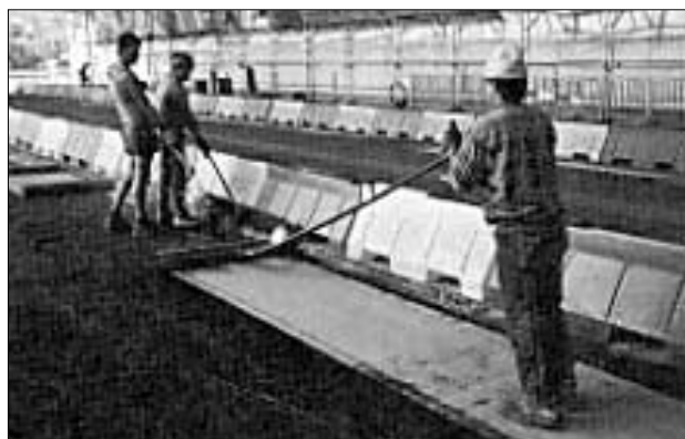
Figure 4.48: Exécution d'une nouvelle étanchéité de pont (polymère-bitume)
