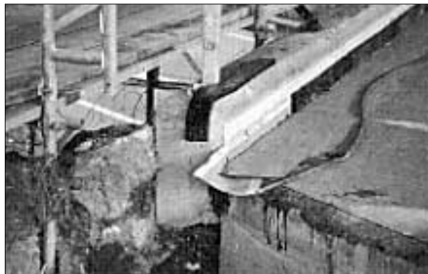
Figure 4.47: Exécution d'une nouvelle bordure lors de l'assainissement d'un pont (étanchéité polymère-bitume)
