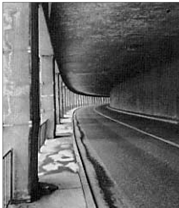
Figure 3.12: A la fin de la période hivernale, on repère très nettement des dépôts de sel le long de la chaussée et sur le trottoir.
