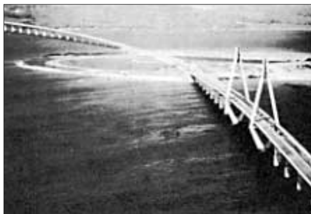
Figure 5.10: Le pont de Farö vu d'avion (tiré de ([5.11]))
