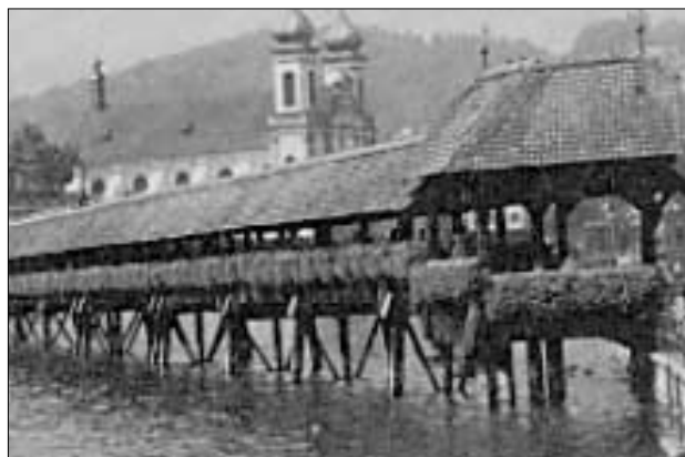
Figure 6.1: Le pont de la Chapelle à Lucerne, édifié en 1333 [7.2]
