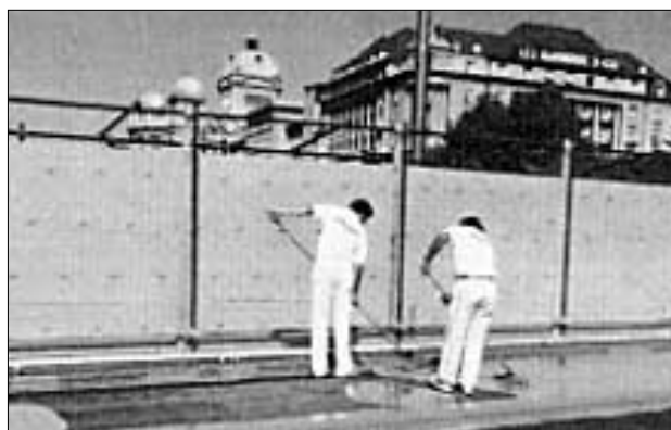
Figure 4.48: Exécution d'une nouvelle étanchéité de pont à l'aide de plastique liquide
