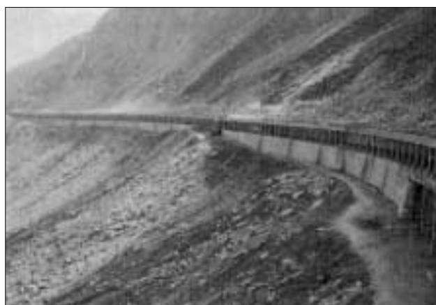
Figure 3.9: Galerie de protection
