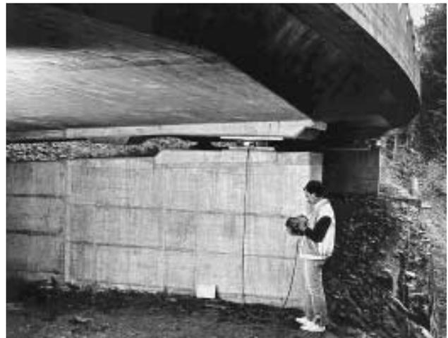
*Appuis du pont de Caselertobel dans le canton des Grisons, équipés pour la mesure des forces. Le pont traverse une zone de glissement, ce qui justifie une surveillance intensive.*
