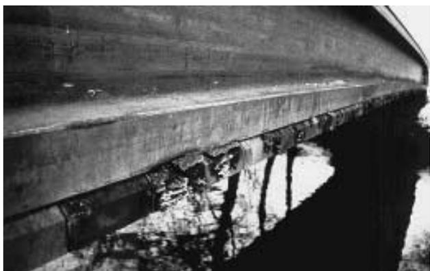
*Une attaque par les champignons (du fait d'une construction non adéquate) est rarement aussi apparente que sur ce pont. Les défauts et dégâts cachés sont bien sûr beaucoup plus délicats à juger.*
