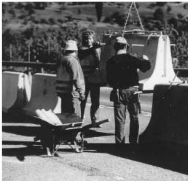
Fig. 64: Montage d'éléments Tric-Bloc
