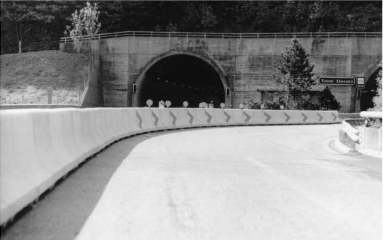
Fig. 40: Barrière réalisée avec des éléments Tric-Bloc
