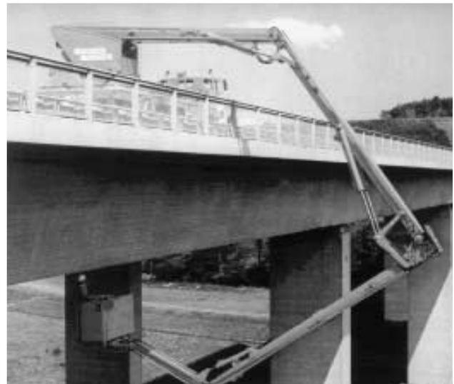
Fig. 49: Utilisation d'une nacelle pour l'inspection d'un pont
