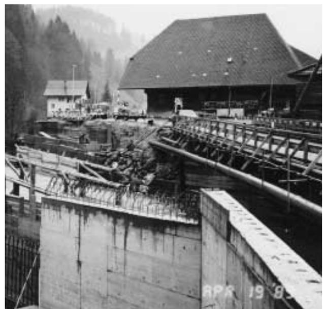
Fig. 41: Pont provisoire sur une route à grand débit
