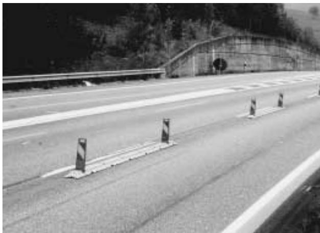
Fig. 39: Variante de balises en cas de trafic bidirectionnel
