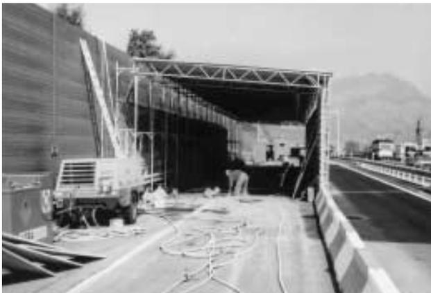
Fig. 51: Utilisation d'un toit de protection lors de l'assainissement d'un tablier de pont
