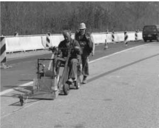
Fig. 33: Travaux de marquage durant l'exploitation
