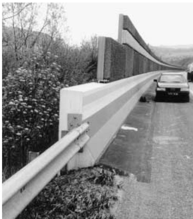
Fig. 43: Utilisation d'éléments préfabriqués (paroi anti-bruit placée sur des éléments New-Jersey)
