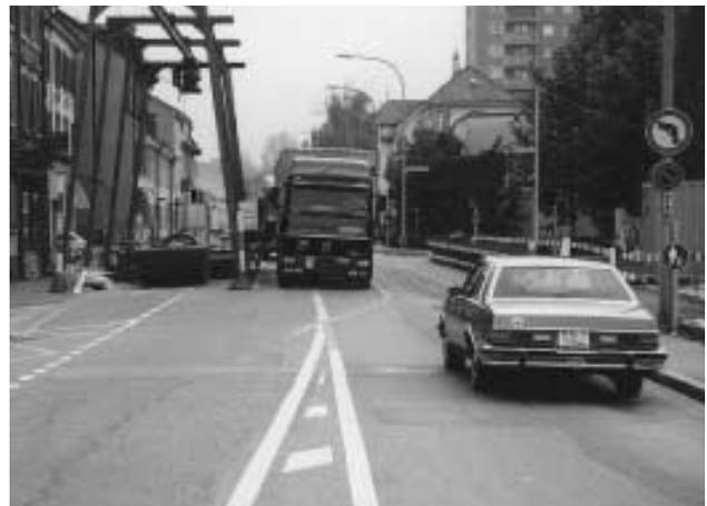
Fig. 25 : Mauvais tracé du marquage de chantier = danger accru d'accident
