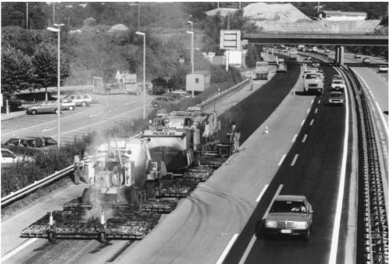
Fig. 47: Renouvellement d'une voie de circulation
