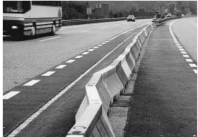
Fig. 24: Balisage avec sécurité latérale insuffisante
