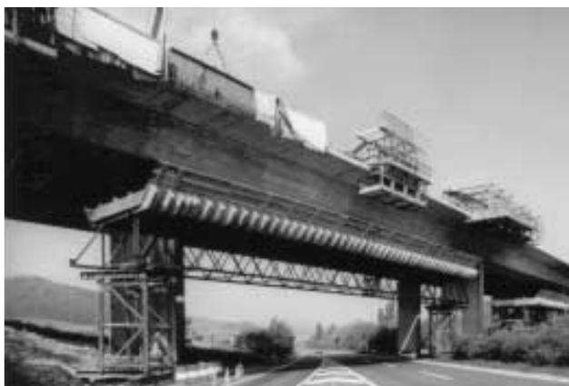
Fig. 46: Exécution par étapes cadencées
