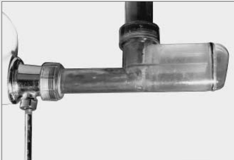
Siphon de lavabo: l'eau contenue dans le siphon empêche les remontées de mauvaises odeurs
