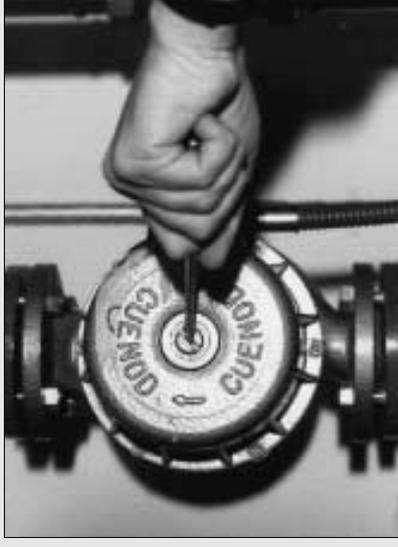
Après avoir retiré le bouchon de purge/l'indicateur du sens de rotation (apparition de gouttes d'eau), débloquent l'arbre du rotor au moyen d'un tournevis. Faire tourner l'extrémité de l'arbre jusqu'à la suppression de la résistance. Revisser le bouchon. Rouvrir les organes d'isolement et remettre la pompe en service.
