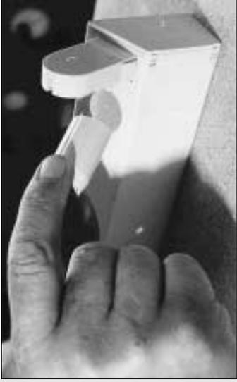
Remplacement du starter d'un tube fluorescent.
