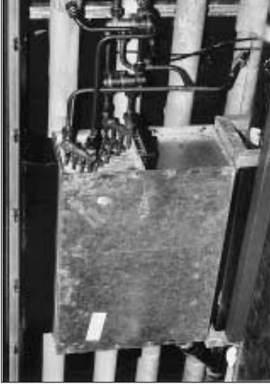
Ventilo-convecteur avec panneau de protection démonté
