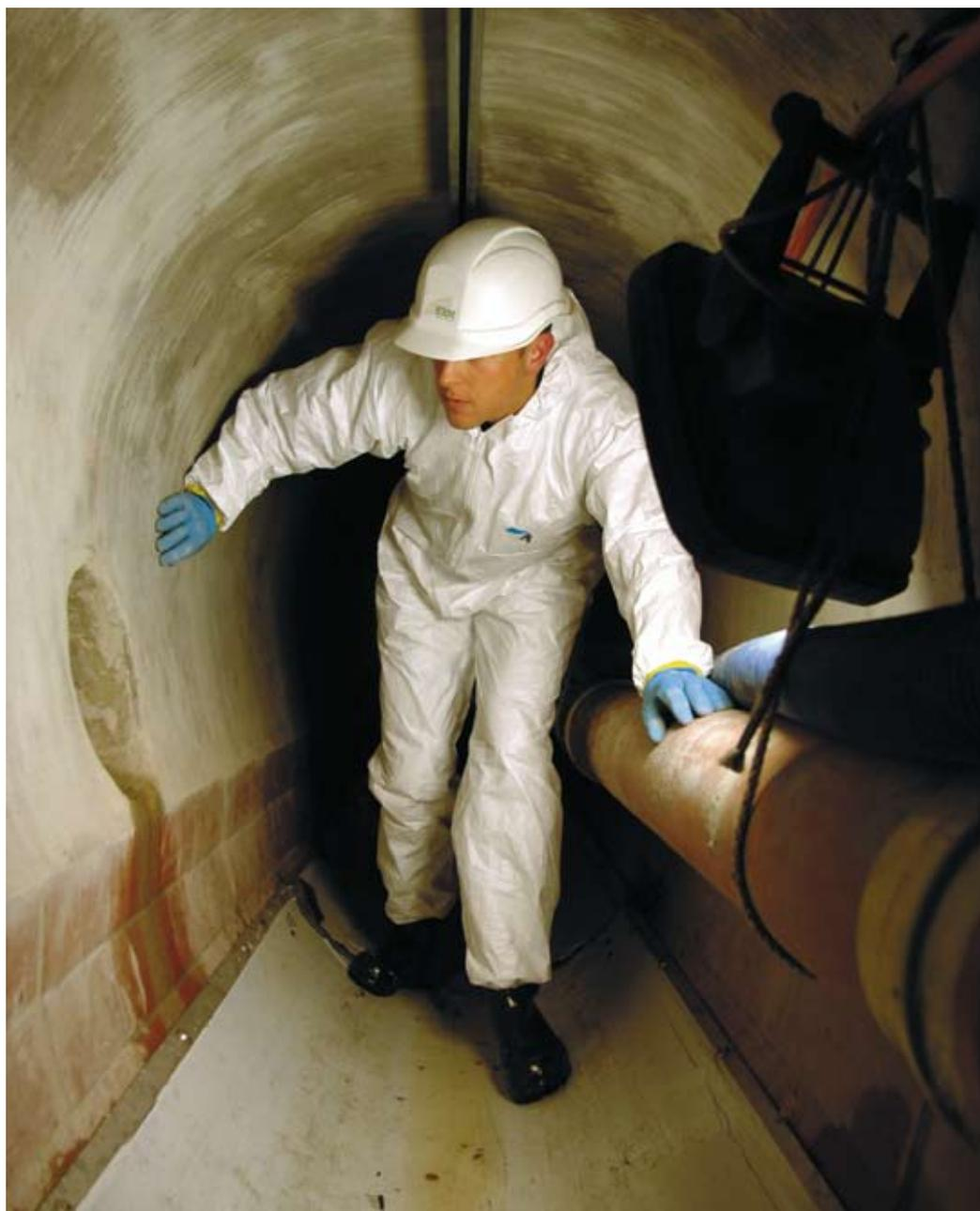
*Dernier contrôle: Dès que les eaux usées coulent, l'échangeur de chaleur en forme de rigole récupère de l'énergie dans le fond de la canalisation. Photo: EBM*
