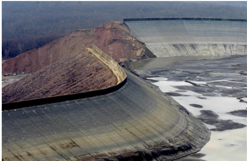
Rupture de barrage par pompage excessif, suite à l'indication de valeurs de mesure erronées provenant de sondes insuffisamment fixées (Taum Sauk, Etats-Unis, décembre 2005).
