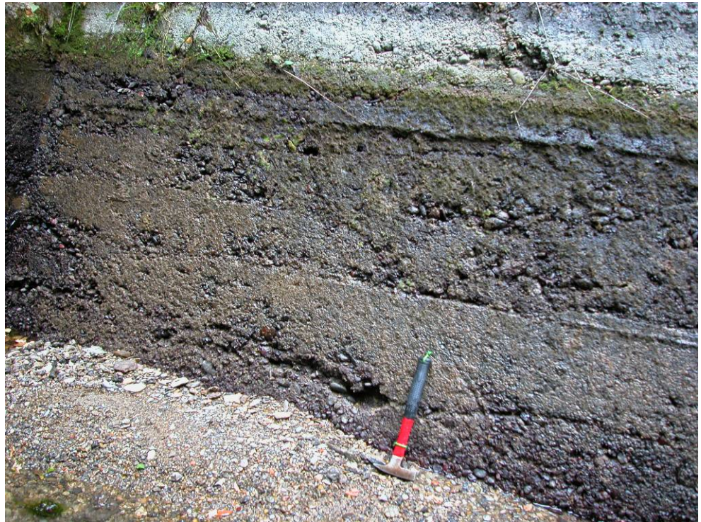
Béton damé, généralement soumis à de faibles contraintes.
