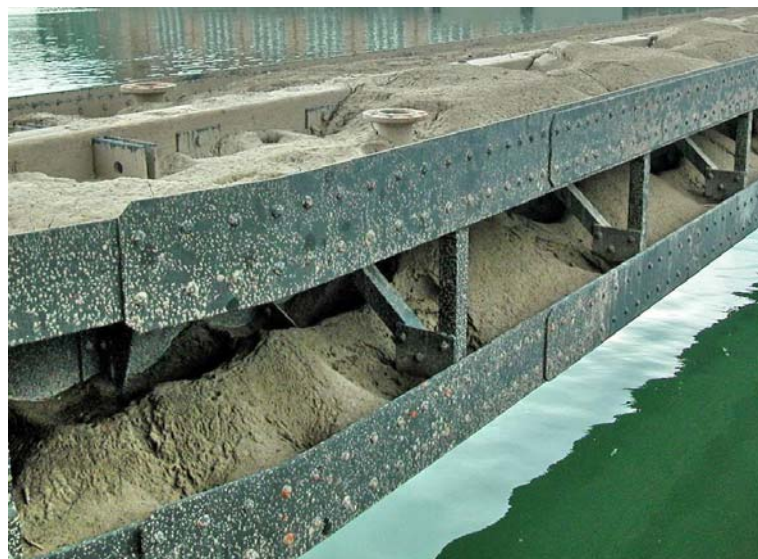
Sédiments sur un batardeau.
