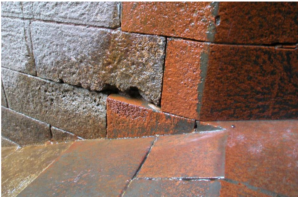
Erosion de pierre en granit de haute qualité due à une dépression derrière une arrête.
