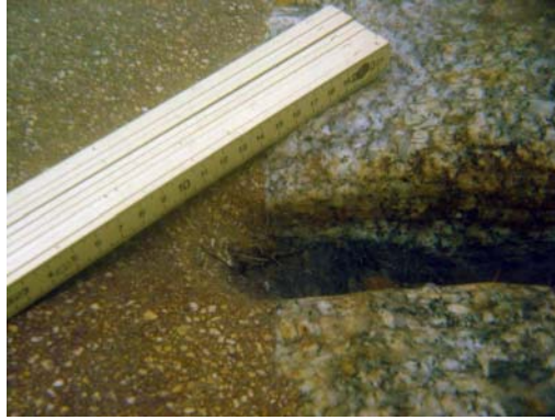
Mortier de joints usé par l'érosion et paroi frontale en béton endommagée.
