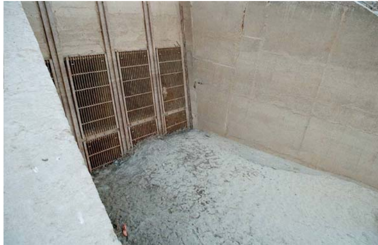
Sédimentation devant la prise d'eau d'une centrale électrique.
