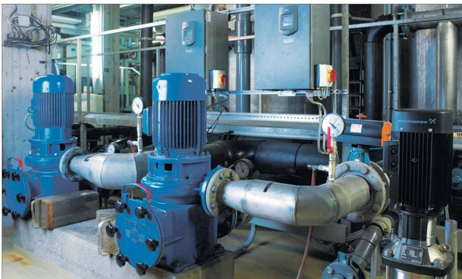
La pose de convertisseurs de fréquence (armoires grises) permet le réglage sans gradations des deux pompes de circulation. En fonctionnement normal, elles tournent aujourd'hui avec une puissance de 45% seulement.
