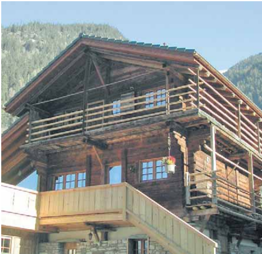
Maison individuelle rénovée à Montagnier/Bagnes (Label Minergie VS-175)
