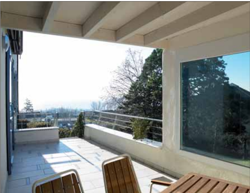
La terrasse a été dotée d'un toit et de longues surfaces d'assise, faites de bois peint en blanc, et disposées le long de la nouvelle balustrade légèrement inclinée vers l'extérieur.
