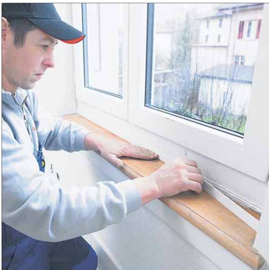
9 Les listeaux de recouvrement ont également été correctement coupés à dimension et proprement collés.
