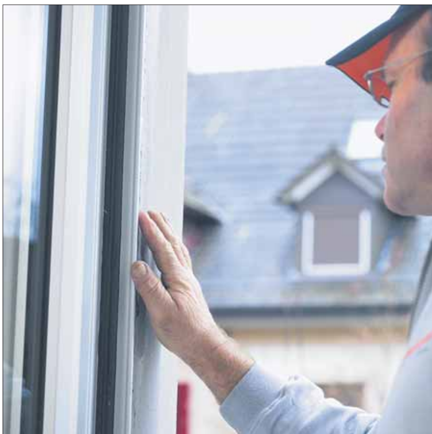
8 Après le contrôle opérationnel, dernier coup d'œil inquisiteur: le joint en silicone a été appliqué proprement à la spatule.
