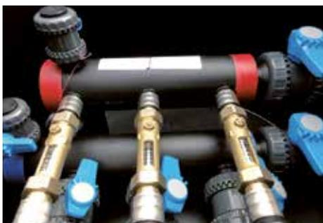
**5 Conduites saumure et affichages de débit:** Toutes les conduites saumure sont verrouillables. Les affichages de débit sont fixés au moyen d'écrous d'accouplement 1/4" et permettant ainsi une maintenance aisée si besoin.
