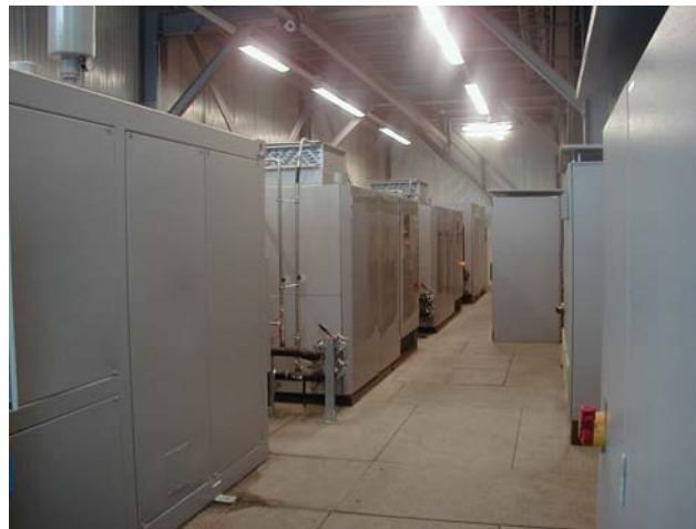
Figure 2 : Installation à air comprimé
