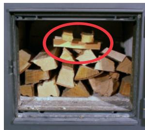
Dans les **poêles à accumulation**, vous disposez les bûches avec la section transversale vers l'avant.
