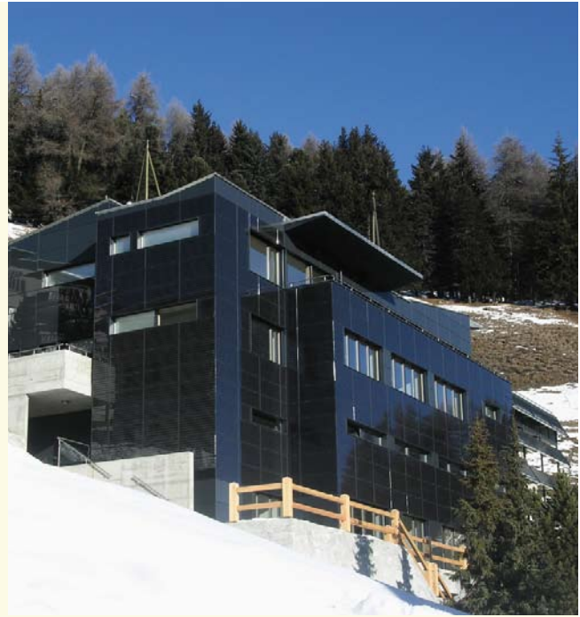
Intégration optimale au bâtiment. Une installation PV en guise de façade d'une maison privée. (Josef Troxler)
