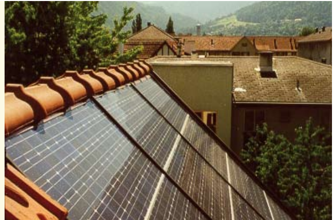
Assainissement réussi d'un toit avec intégration d'une installation solaire photovoltaïque. (Raimund Hächler)
