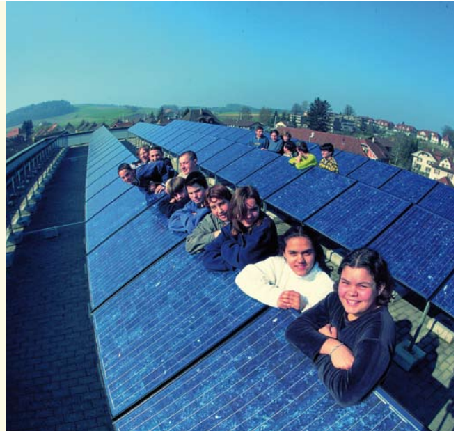
Modules solaires sur châssis sur le toit plat d'une école. (Patrick Lüthy)
