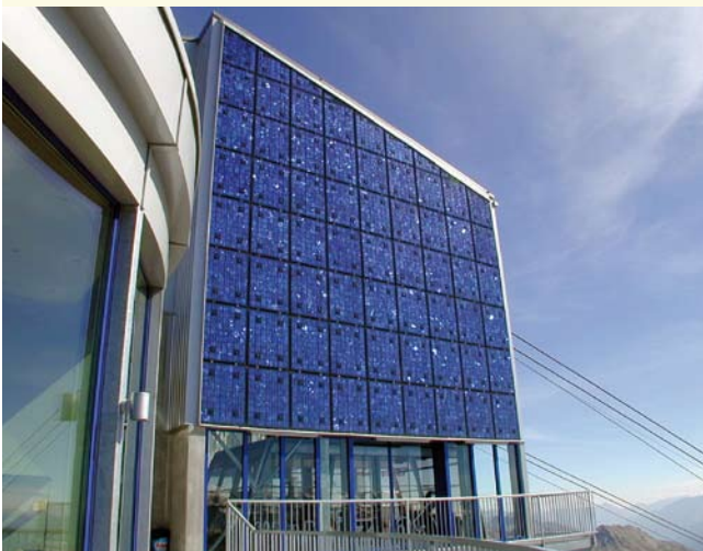
Installation PV à cellules solaires microcristallines intégrée en façade. (NET AG)
