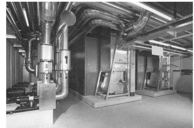
Fig. 7: Centrale de production d'énergie de l'hôpital cantonal d'Obwalden avec deux BCT (à gaz Propane).
