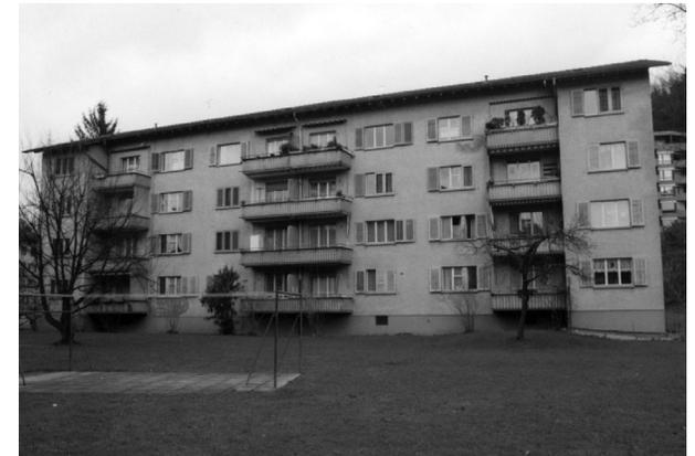
Immeuble locatif avec sous-sol, 4 étages et grenier sous toit à 2 pans, avec couverture de tuiles. Les balcons sont formés d'une dalle de béton armé en porte-à-faux; particulièrement lors d'une isolation périphérique complémentaire, ceux-ci représentent des graves points faibles (ponts thermiques).
