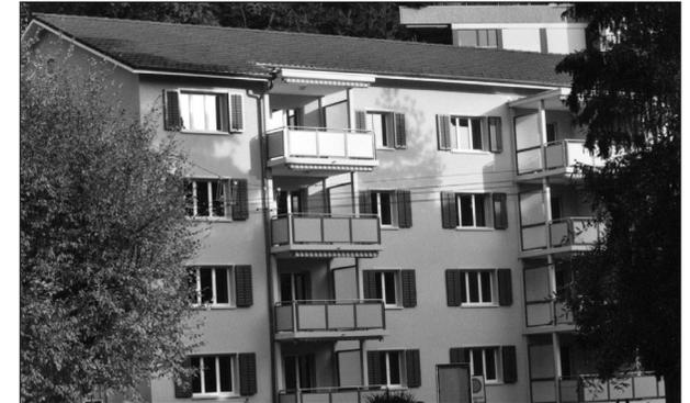
A part les nouveaux balcons, l'aspect extérieur des maisons rénovées n'a pas beaucoup changé. Les nouveaux balcons spacieux disposent d'une structure porteuse indépendante, grâce à laquelle ils n'ont plus d'interaction thermique avec les bâtiments existants. Cette transformation d'un élément du bâtiment a pu être résolu de façon optimale du point de vue thermique et énergétique.
