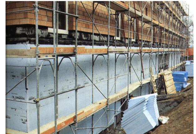
Fig. 3: Immeuble d'habitation à Zurich, isolation périphérique de plaques de polystyrène collées
