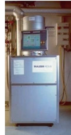
Voici à quoi ressemble une chaudière à pile à combustible
