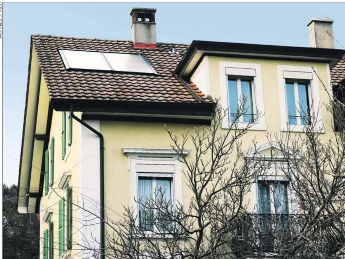
Les capteurs solaires ont été montés en premier lieu. Sont maintenant inscrits au programme l'isolation intérieure du toit, les fenêtres à isolation thermique et le chauffage à granulés de bois.
