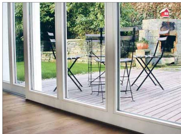
A l'inverse des anciennes fenêtres en verre isolant ou à double vitrage, les fenêtres à isolation thermique modernes ne laissent plus échapper que la moitié de la chaleur.
