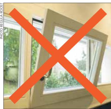
Ne laissez les fenêtres basculantes ouvertes qu'en été, car une telle fenêtre ouverte en permanence consomme 4 litres de mazout par journée froide en hiver.
