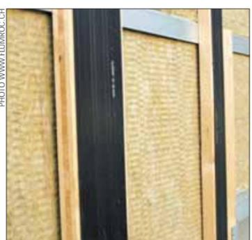
Avec la façade ventilée, une sous-construction est nécessaire pour le revêtement.
