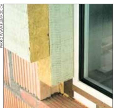
Les plaques d'isolation d'une façade compacte sont collées sur le mur.
