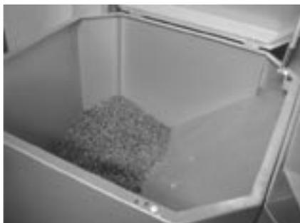
Réservoir de 275 litres, attaché à la chaudière
