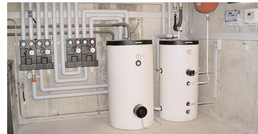
Sur la droite, l'accumulateur tampon de 300l et à gauche, trois groupes distribution à deux niveaux de température et un groupe de charge pour le chauffe-eau de 400l.
