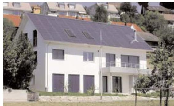
*La maison solaire de la famille Erni est un bon exemple de combinaison d'une installation photovoltaïque et d'une pompe à chaleur. L'installation solaire a une puissance de 11,7 kW et elle produit donc dans les 11 500 kWh de courant par année.*
