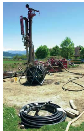
Forage de 33 sondes de 145 m de profondeur à proximité du centre d'étude de la BNS à Gerzensee.
