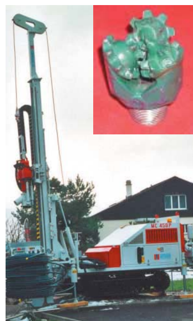
Foreuse montée sur chenilles. En haut à droite: une tête de forage appelée triconne à mollettes. En bas à gauche on distingue les torches de tubes qui constituent la sonde avant leur introduction dans le trou de foré.
