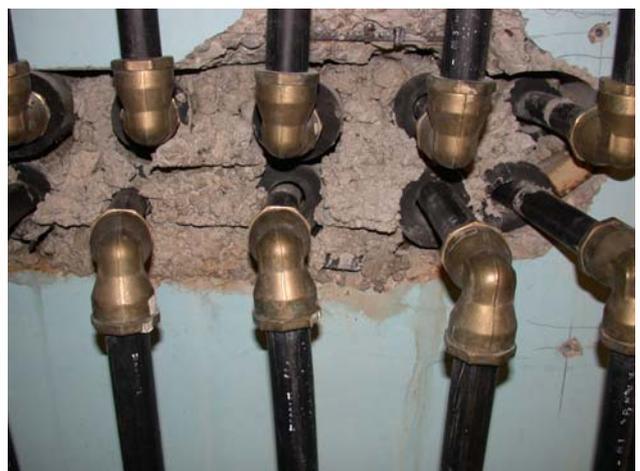
Il s'agit très rarement d'un problème de pompe à chaleur. Ces photos démontrent avec quelle négligence la traversée du mur a été effectuée. Une infiltration d'eau dans le sous-sol et le mauvais remplissage des sondes ont provoqué quelques soucis au propriétaire de cette installation !
