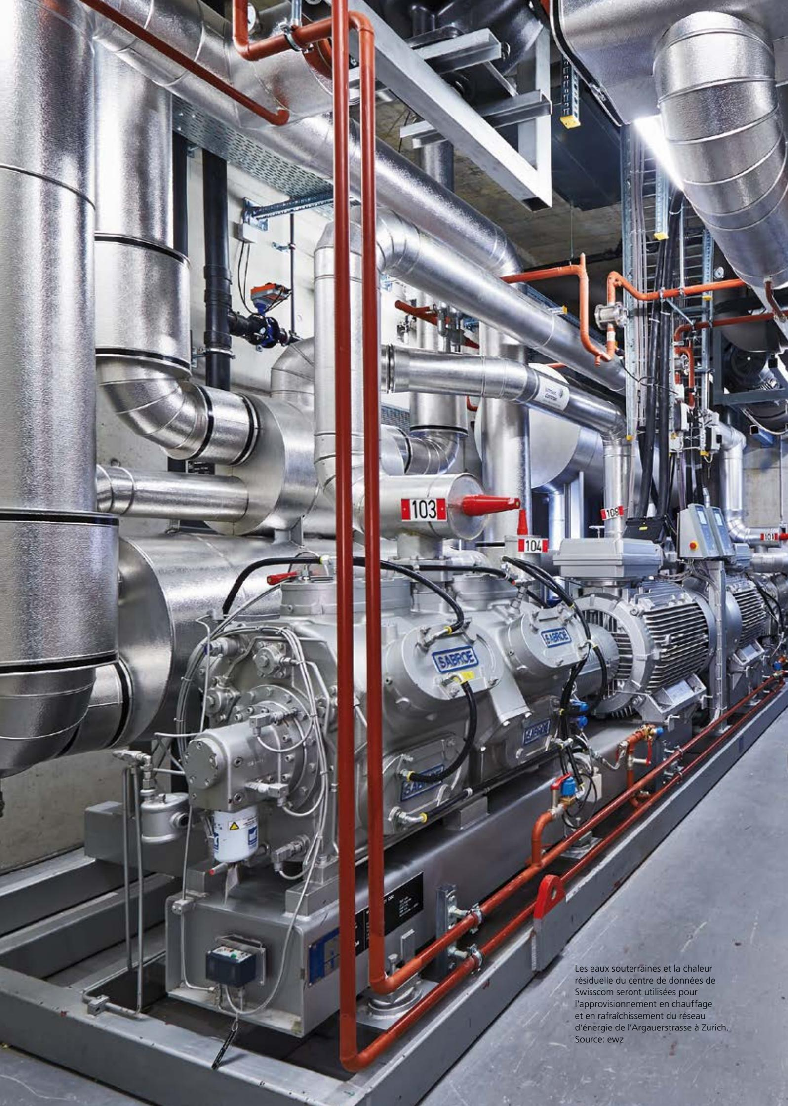
Les eaux souterraines et la chaleur résiduelle du centre de données de Swisscom seront utilisées pour l'approvisionnement en chauffage et en rafraîchissement du réseau d'énergie de l'Argauerstrasse à Zurich. Source: ewz
