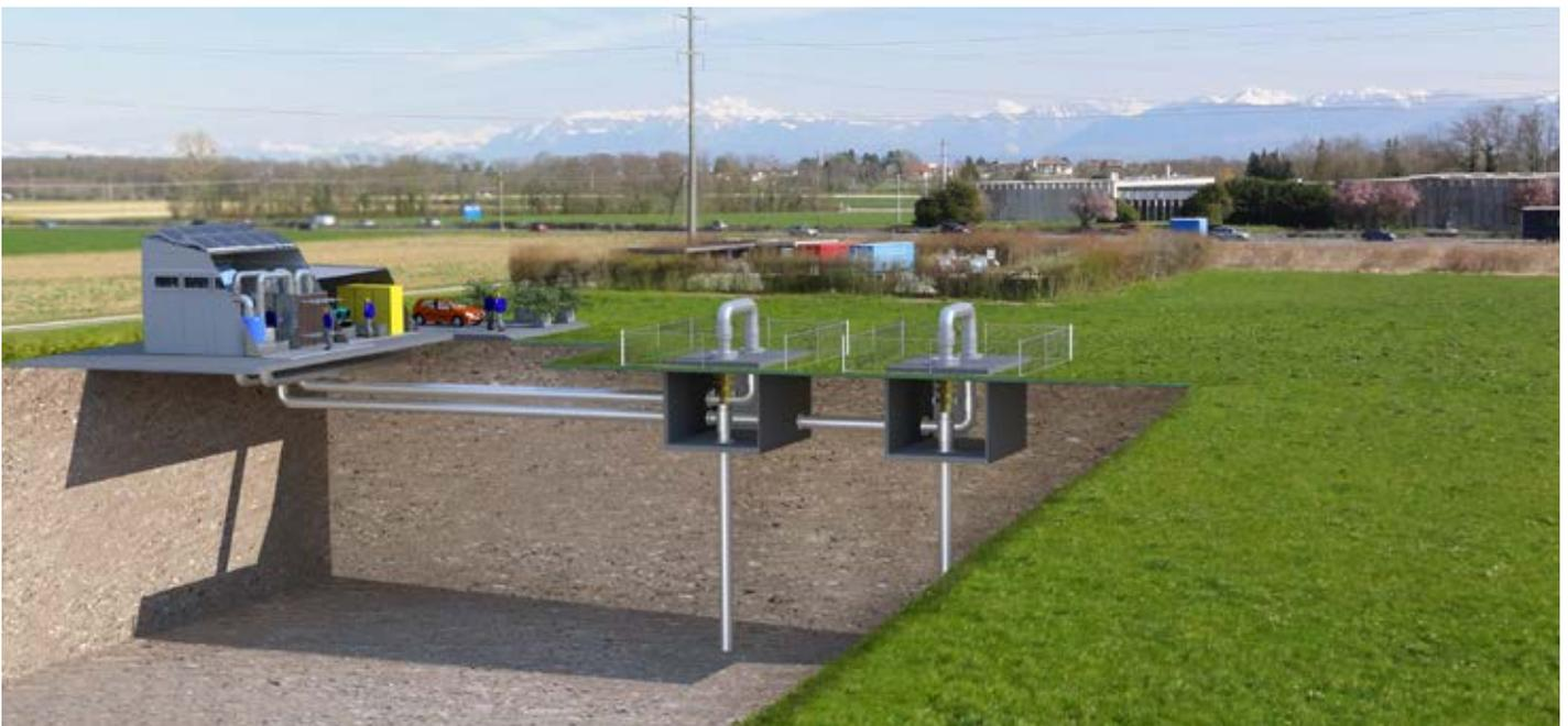
Centrale géothermique du projet de moyenne profondeur EnergieÖ à Vinzel (VD), avec puits de production et de réinjection – image de synthèse. Source: EnergieÖ
