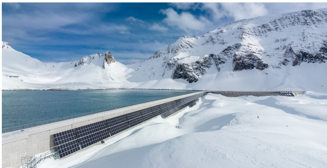
Une autre forme d'hybridation : depuis août 2022, une installation solaire située sur le barrage du lac de Mutt, dans les Alpes glaronaises, fournit quelque 3 millions de kWh par an. Le rendement est relativement élevé pendant les mois d'hiver. Photo : Axpo
