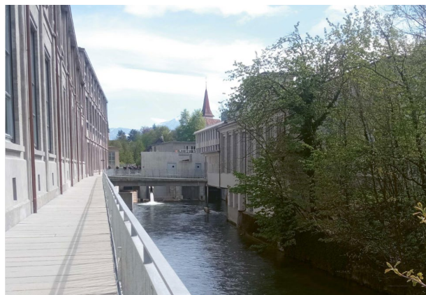
Centrale hydroélectrique de Papieri Cham (ZG) (source: Mhylab)
