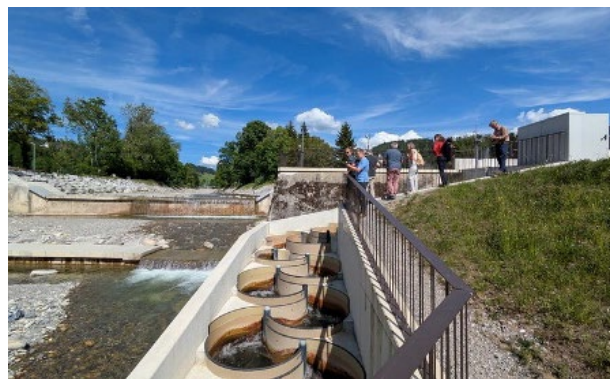
Passes à poissons en méandres de la centrale hydroélectrique de Zug à Steffisburg (Source: SSH 2026)
