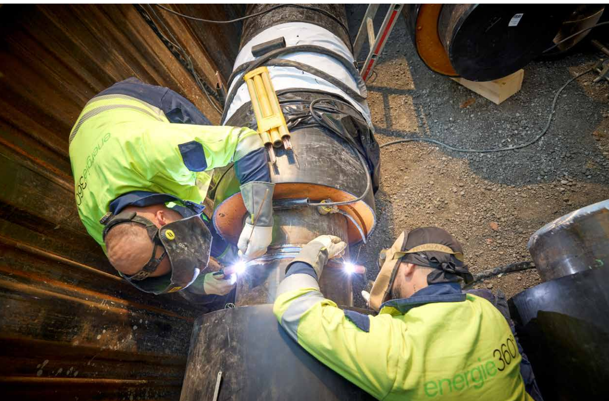
Les conduites posées à Volketswil pour le nouveau réseau de chauffage à distance font 60 cm de diamètre, soit beaucoup plus que ceux d'autres projets. Ce chiffre illustre l'ampleur du réseau et, par conséquent, le potentiel des rejets thermiques des centres de données en tant que source d'énergie. (Photo: Energie 360°)
