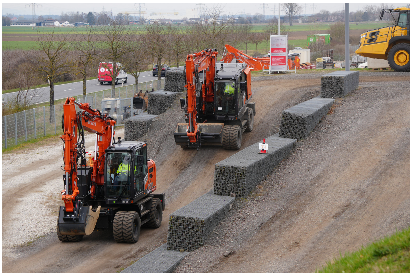
Utilisation de la pelle mobile diesel (à l'avant) et du prototype électrifié (à l'arrière) sur un terrain d'essai. Lors des essais de conduite, la consommation d'énergie a notamment été mesurée. Photo : rapport final de l'OFEN
