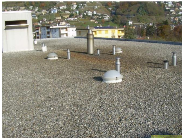
Tetto piano con carta catramata e ghiaia, isolamento scarso (6cm)
