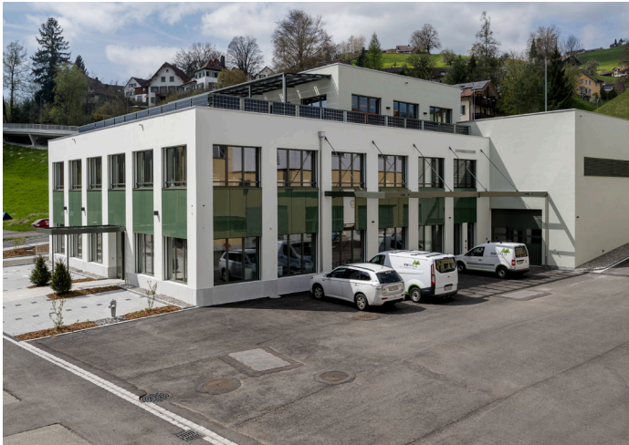
Sous le parvis asphalté de la centrale électrique de Wald, un capteur en asphalte composé de 17 modules a été installé en 2022 dans le cadre de la construction du nouveau bâtiment d'exploitation. Photo : EW Wald AG
