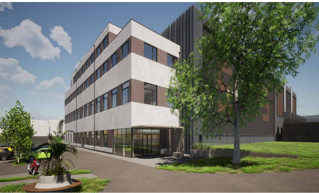
Le centre de données de Beringen après son achèvement. (Simulation: Stack Infrastructure)
