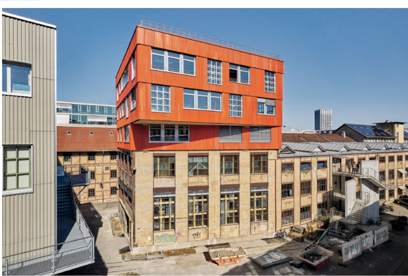
Winterthour: le K.118 a été réalisé à 70 % avec des matériaux de construction recyclés.
