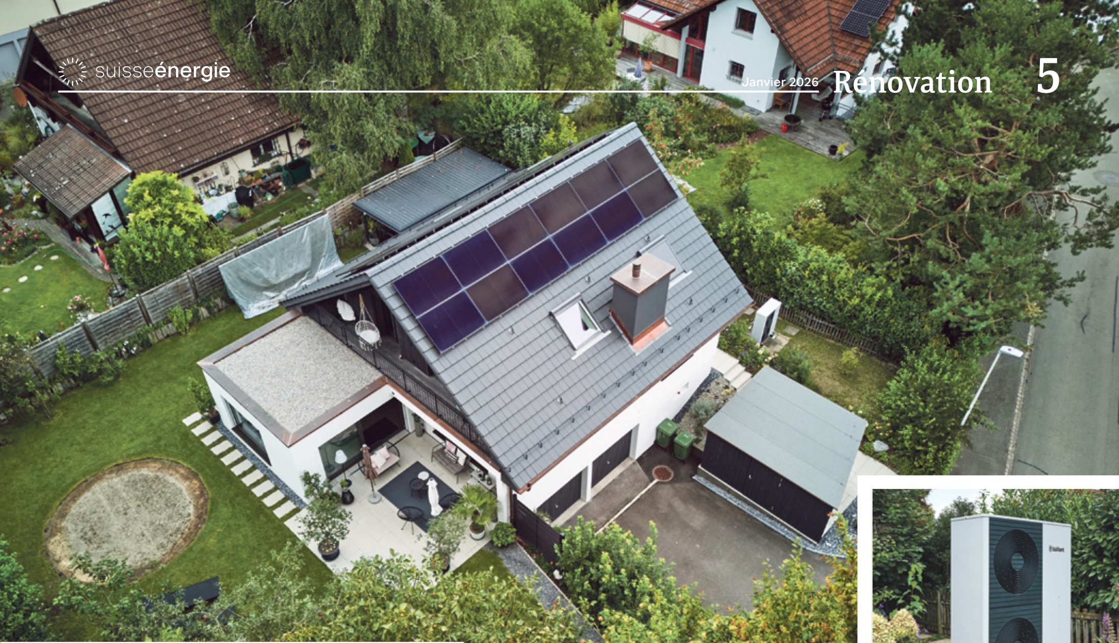
Le couple a d'abord rénové le toit de la maison, qui a ensuite été équipé d'une installation photovoltaïque de 10,4 kWc.
