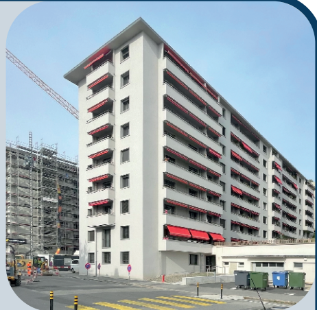
Rénovation des bâtiments Boisy ©Hindernisfreie Architektur
