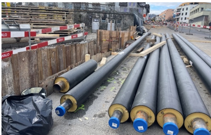
Pose des canalisations de chauffage urbain dans le centre-ville d'Eschenbach
