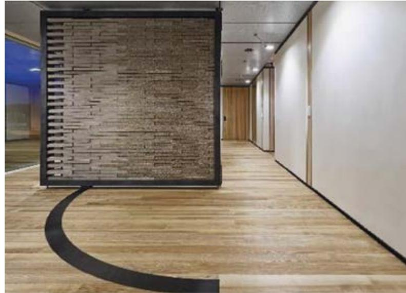
Figure 7.5: La cloison mobile se compose de briques recyclées enfilées sur une grille métallique, sans mortier. (Photo: Zooey Braun, Stuttgart)
