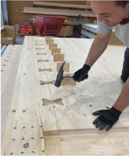
Figure 6.5: Afin de garantir la séparabilité des composants, les concepteurs de la construction à ossature bois ont opté pour des assemblages par emboîtement et par vis. (Photo: Tschopp Holzbau AG)
