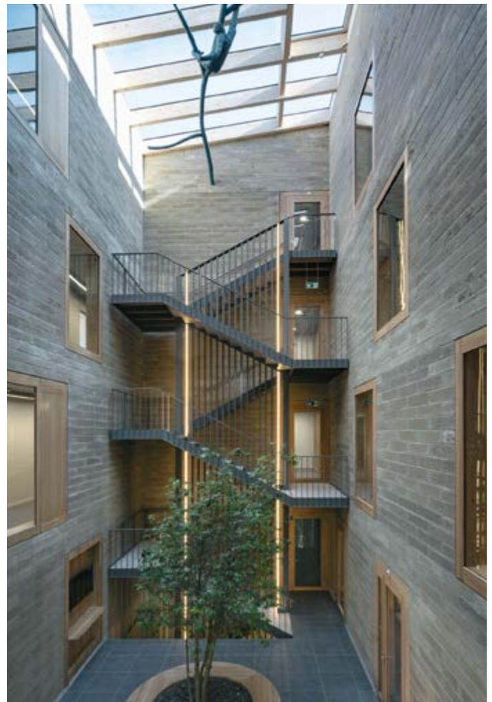
Figure 5.2: L'un des deux atriums qui non seulement apportent beaucoup de lumière naturelle dans le bâtiment, mais influencent également positivement le climat intérieur grâce à l'effet de cheminée et aux briques d'argile utilisées. (Photo: Duccio Malagamba)
