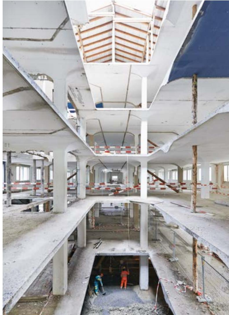
Figure 3.5: Les nouvelles cages d'escalier ont nécessité des découpes dans la structure porteuse. (Photo: Studio Gataric Fotografie)
