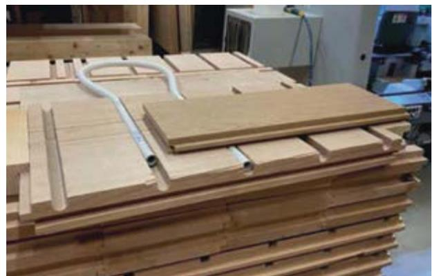
Figure 6.2: Composition du sol dans les étages de bureaux de la «Maison du bois». Les tuyaux du système de chauffage et de refroidissement ne sont pas coulés dans le béton, mais peuvent être enlevés très facilement. (Source: PIRMIN JUNG Schweiz AG)
