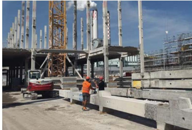
Figure 7.3: Les piliers, poutres et éléments de plafond de l'ancien parking Lysbüchel à Bâle sont démontés élément par élément et seront ensuite réemployés dans deux nouveaux bâtiments. (Photo: Muriel Mangold)
