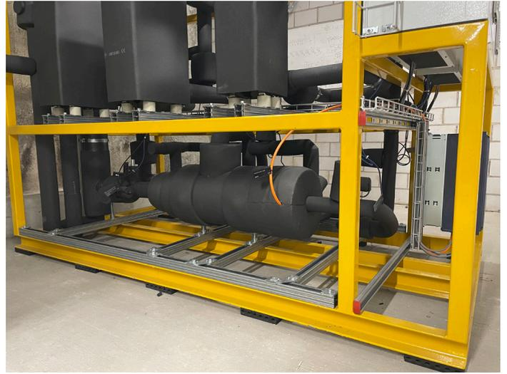
Installation frigorifique au CO<sub>2</sub> avec ETS dans le magasin Prodega de Saint-Gall. L'ETS y est mis en œuvre sous sa forme la plus avancée, à savoir avec une pompe radiale résistante à la pression. L'installation de réfrigération avec ETS a été mise en service en octobre 2024. Elle a une puissance frigorifique de 180 kW (comparable à la puissance frigorifique du magasin Prodega de Dietikon). Photo : Frigo-Consulting AG
