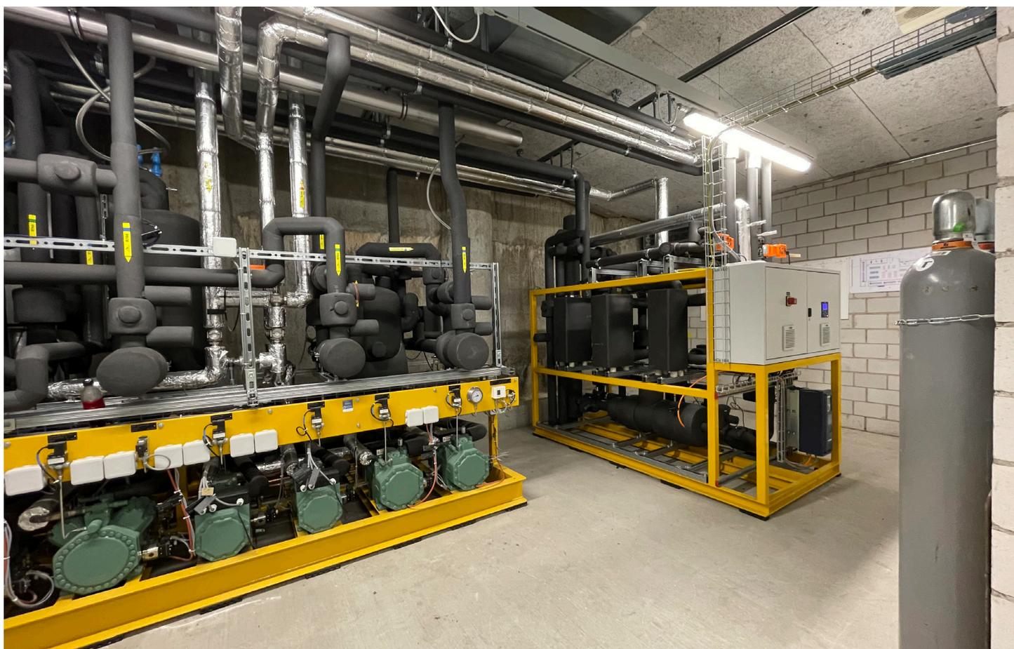
Installation frigorifique au CO<sub>2</sub> avec ETS dans le magasin Prodega de Saint-Gall. L'ETS y est mis en œuvre sous sa forme la plus avancée, à savoir avec une pompe radiale résistante à la pression. L'installation de réfrigération avec ETS a été mise en service en octobre 2024. Elle a une puissance frigorifique de 180 kW (comparable à la puissance frigorifique du magasin Prodega de Dietikon). Photo : Frigo-Consulting AG
