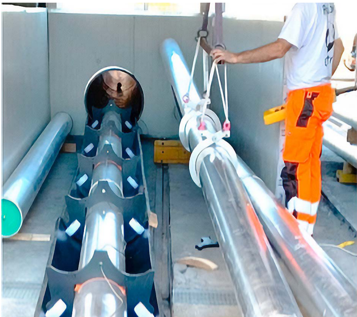
Un système de rouleaux développé en interne est utilisé pour le montage. Les tubes de câbles sont tirés dans le tube de protection à l'aide d'un câble de traction (source : Hivoduct).
