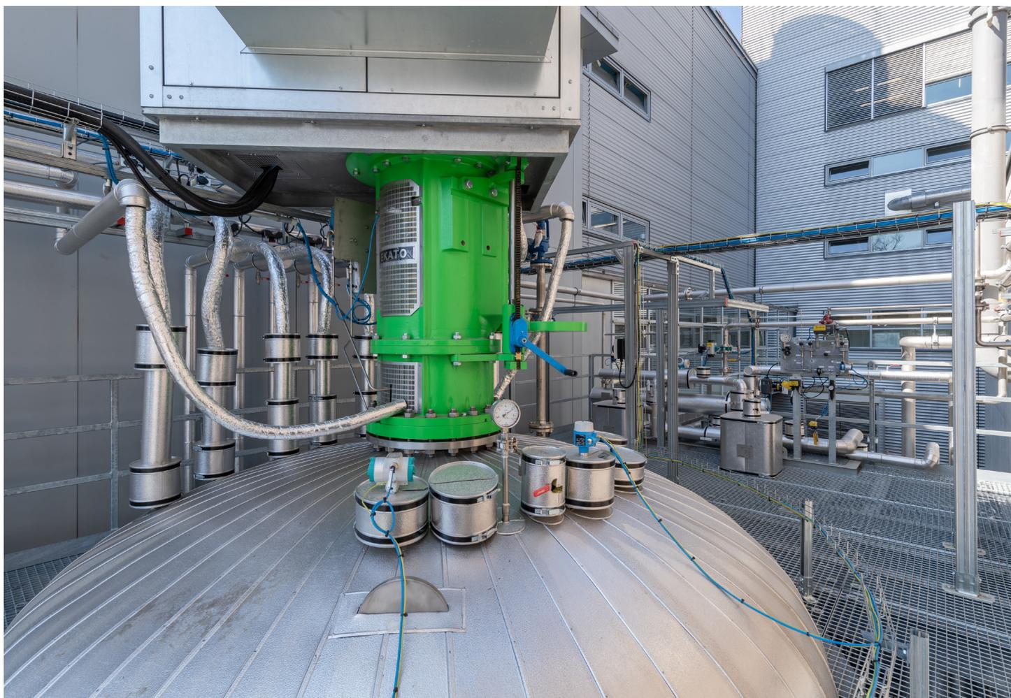
Le bioréacteur mesure huit mètres de haut et trois mètres de diamètre. En fonctionnement normal, il est rempli de 30 m<sup>3</sup> de boues d'épuration digérées, lesquelles contiennent les micro-organismes qui transforment le dioxyde de carbone (CO<sub>2</sub>) et l'hydrogène (H<sub>2</sub>) en méthane (CH<sub>4</sub>). Pour ce faire, le réacteur est équipé d'un agitateur spécial. Dans le réacteur, la température est de 65 °C et la pression de 7 bars. Photo : Limeco
