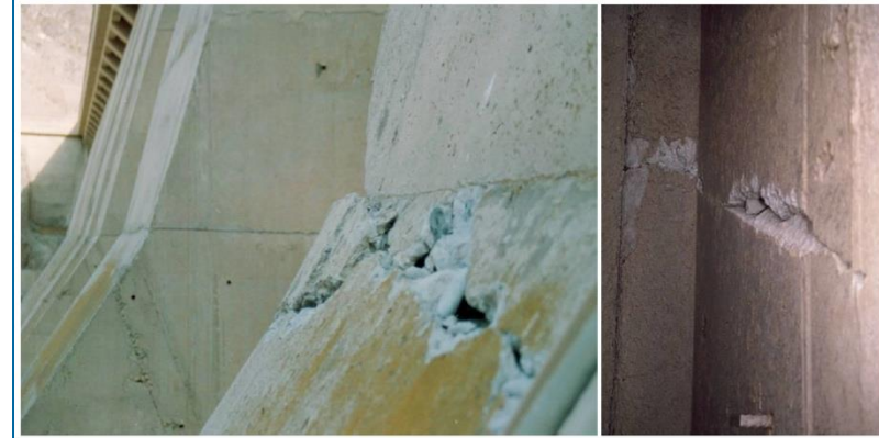
Fissuration au niveau de changement de pente des contreforts (gauche) et au droit d'une reprise de bétonnage (droit)
