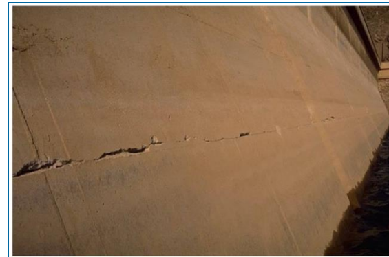
Fissuration du parement amont au droit d'une reprise de bétonnage
