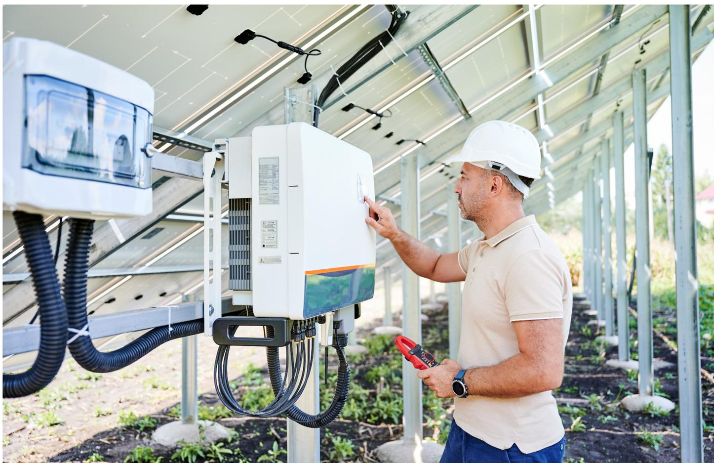
La protection RI de l'onduleur permet de déconnecter une installation PV du réseau en cas de besoin. Photo: Shutterstock
