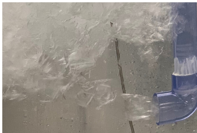
Le coulis de glace circule dans le réservoir de l'accumulateur. Photo: OST
