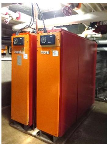
Figure 4 : Chauffe-eaux alimentés par les chaudières
