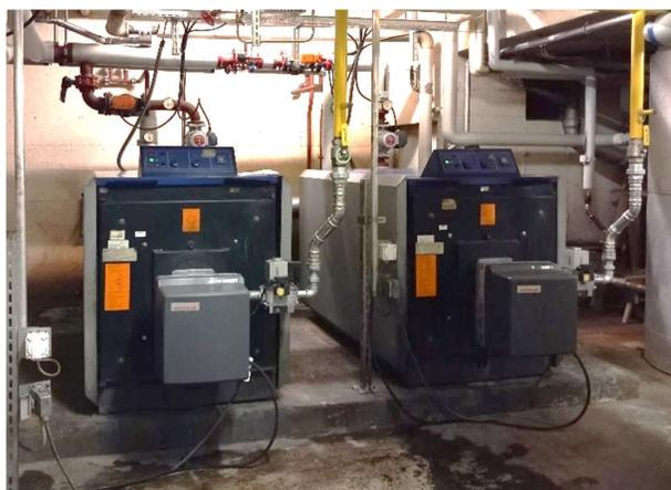
Figure 2 : Chaudières au gaz – 2x 400 kW
