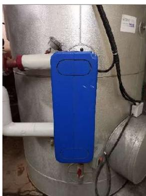
Figure 4 : Chauffe-eau avec échangeur externe alimenté par les chaudières
