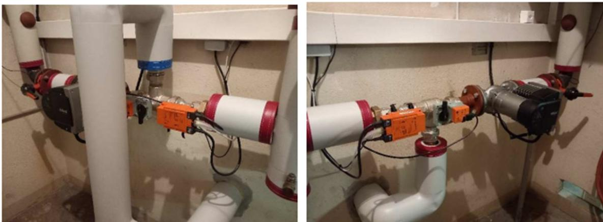
Figure 8: montage des Energy Valves, rue Dancet (distribution Est à gauche et Ouest à droite)
