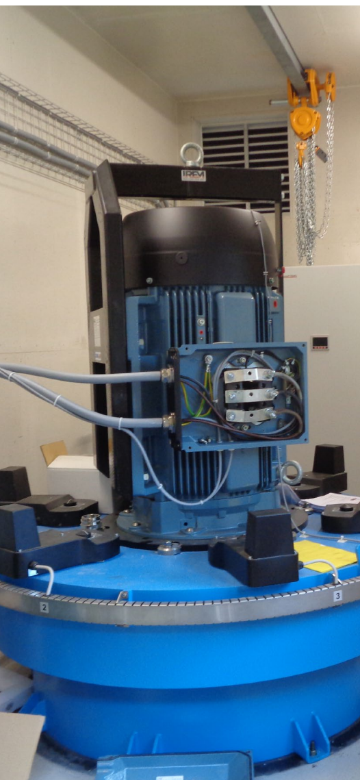
Remise en service après 90 ans de la petite centrale hydraulique de Furlibach, l'intérieur du local de turbinage équipé d'un turbogénérateur Pelton à 6 injecteurs (photo de gauche) et l'extérieur de ce local (photo de droite), © fmb Ingenieure
