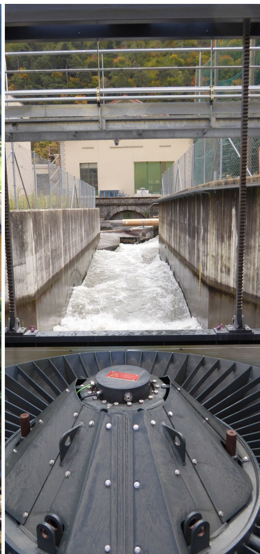
La turbine VLH (Very Low Head), installée dans le canal de fuite de la centrale de Martigny-Bourg (Valais), © MJ2 Technologies
