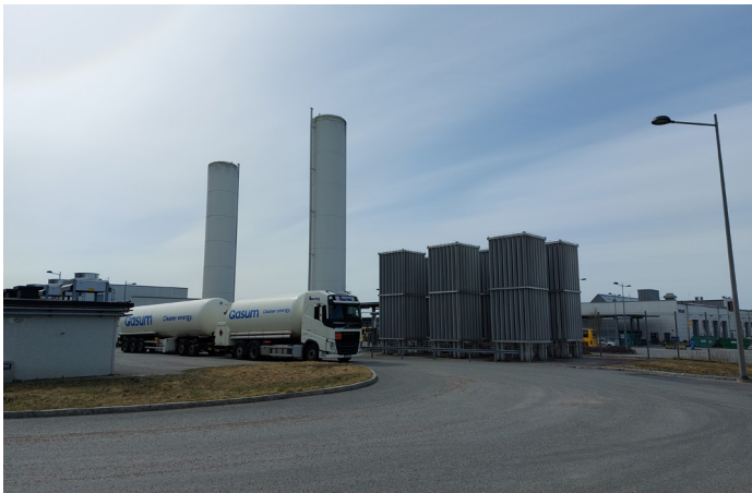
Uppsala Vatten exploite également une installation qui reconvertit le gaz naturel liquéfié (GNL) et le biogaz liquéfié (bioGNL) à l'état gazeux. Photo : OST
