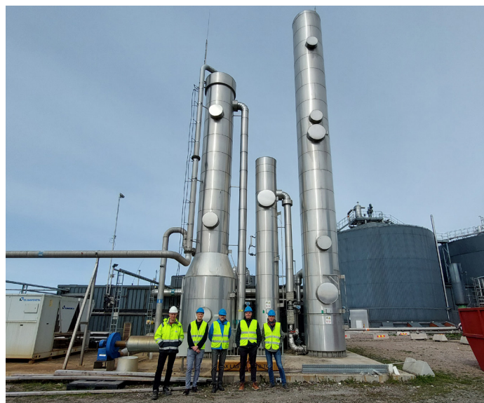
Les membres de l'équipe de projet helvético-suédoise devant l'installation de biogaz d'Uppsala Vatten à Uppsala (Suède). L'installation de biogaz sépare le \text{CO}_2 du biogaz brut afin de produire un biogaz de haute qualité avec une teneur en méthane proche de 100%. Photo : OST
